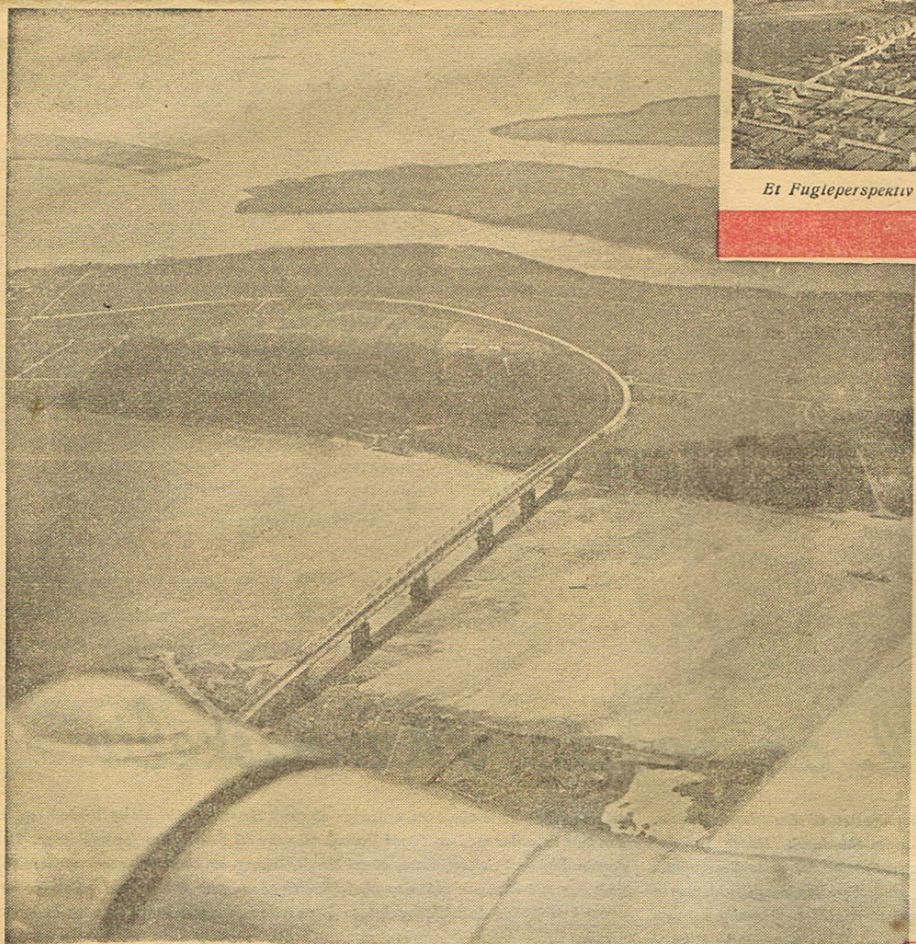
Ogsaa fra Luften præ-senterer Lillebæltsbroen sig som et smukt og imponerende Bygningsværk.
