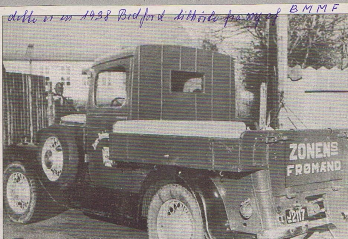
ZONE-REDNINGSKORPSET (8) - Også dette billede illustrerer Zonens evne til at klare sig med beskedne midler. På et tidspunkt anskaffedes denne ældre Chevrolet (?), som vistnok oprindeligt havde været en personvogn, men nu blev »beskåret« og udstyret med et lille lad, så man fik en praktisk halv tons lastbil. Den blev kaldt »gasbilen« - af en grund som der senere skal fortælles om (!!!!), men da Zonen i løbet af 50'erne udvidede aktiviteterne med svømmedykkere (frømænd) fandt vognen også anvendelse ved transport af deres grej, og en malekyndig zoneredder forsynede bagsmækken med en lidt uautoriseret påskrift.
