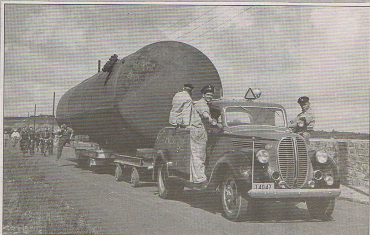
ZONE-REDNINGSKORPSET (15) - Et andet eksempel på Zonens entreprenøropgaver. I Nexø skulle en stor gastank, vistnok i begyndelsen af 50'erne, transporteres til et lageranlæg på havnen. Igen måtte den gamle Ford-kranvogn lægge kræfterne i, og tanken blev klodset op på to blokvogne - på en måde vore dages arbejdstilsyn nok havde været lidt utilfreds med. På bilens højre trinbræt ses den daværende zoneleder i Nexø, Herman Koch, og på v. trinbræt skimtes kørelærer Poul Olsson, Rønne, som var en af flere »løse« medarbejdere ved Zonen.
