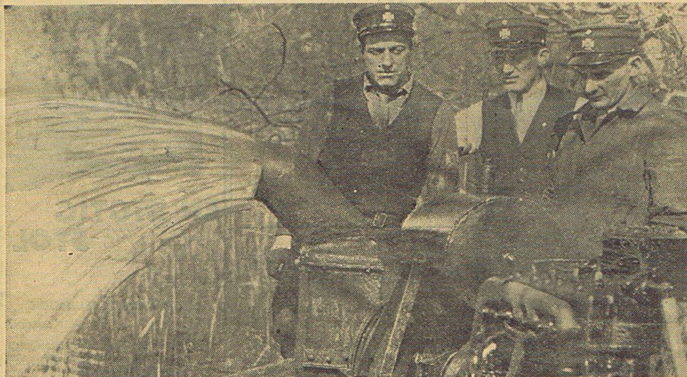
10,000 Minut-Liter-Pumpe, der anvendes ved store Udpumpninger.
